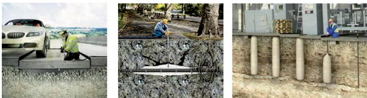
Rys. 5. Przykładowe zastosowanie geopolimerów: a) poziomowanie, b) wypełnianie kawern, c) wsparcie strukturalne
